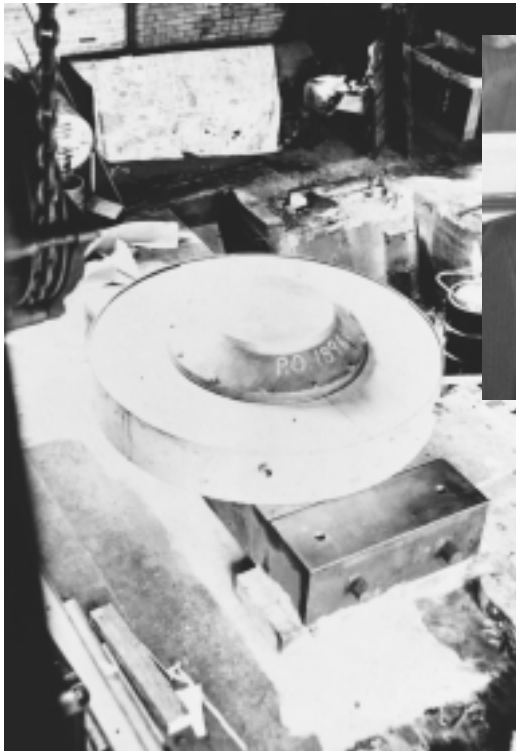
Ciclotrón magnético Chicago a medio ensamblar. Este ciclotrón, el segundo del mundo, lo diseñó y construyó el finado doctor Robert Moon y un equipo de alumnos del doctor William Harkins en la Universidad de Chicago en 1936. (Foto: cortesía del doctor Robert Moon).
