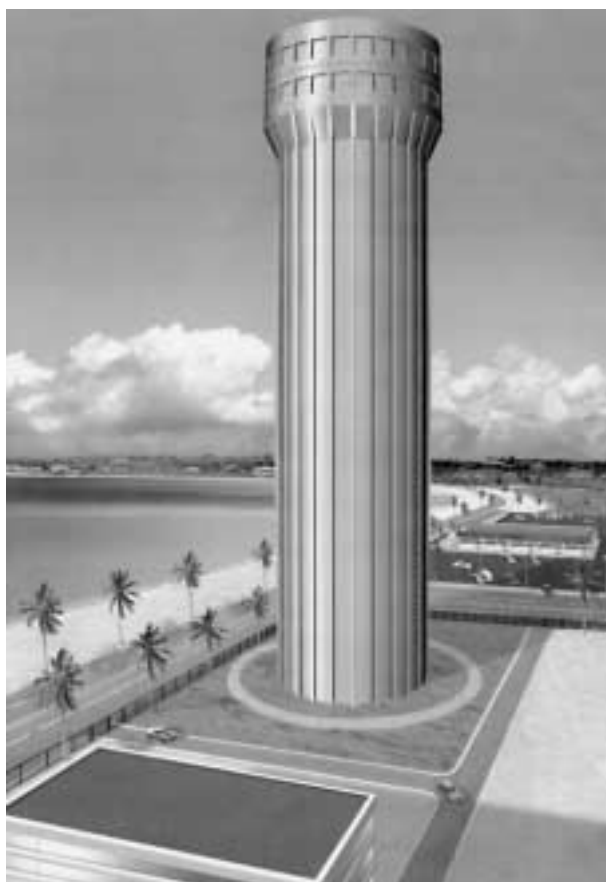
Representación artística de una moderna torre de desalación de agua de mar, que se instalaría en la costa del Pacífico, en California. La estructura alberga un proceso de destilación de efecto múltiple (evaporadores montados de forma vertical) para la producción de agua a gran escala (284.000 m 3 diarios).
